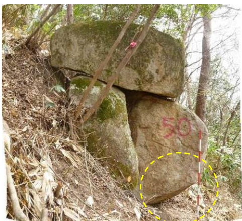
写真-1.1.1 根固マットの設置が困難な例
