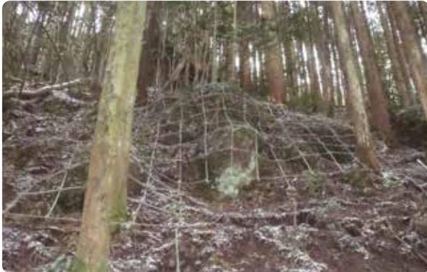
ワイヤーネットを用いた落石発生源対策の多くは覆式落石防護網工に準じた設計手法であり、不安定な岩塊/群を格子状のワイヤーネットで“覆う”ことにより固定するものです。
