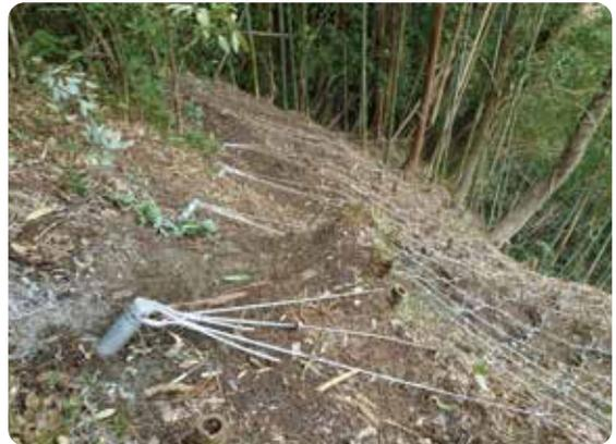
ワイヤーネットとアンカーピンだけで転石群の安定が保たれない場合は、安定した岩盤に定着させる深層アンカーを用います。
