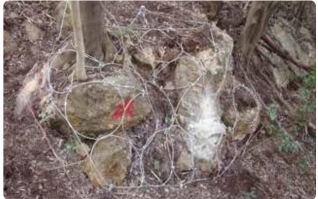
ワイヤーネット被覆工法は不安定な岩塊/群を自在性の高いワイヤーネットで巾着(密着)状に“被覆”することで、ワイヤーネット自体の抑止力を高めようとするものです。
